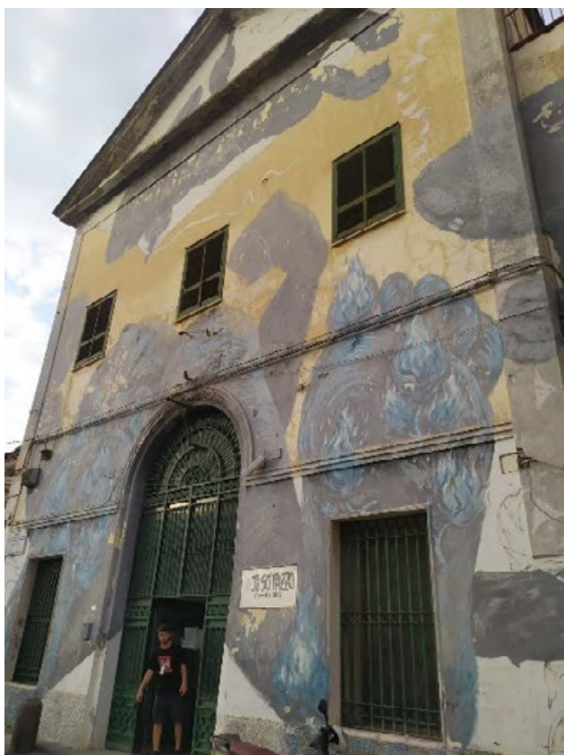
FIG. 6.5 - Facciata esterna e portone d'ingresso Ex OPG Je so' pazzo
